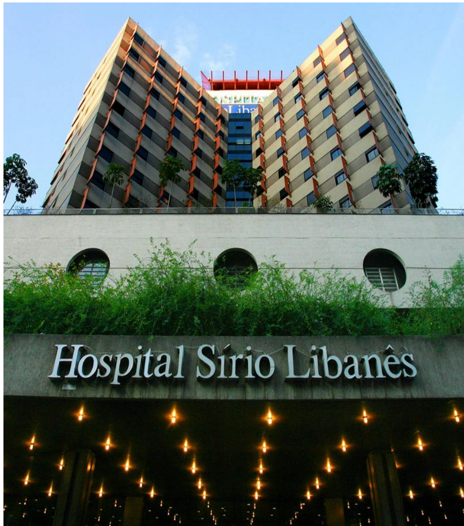
Hospital Sírio Libanês
